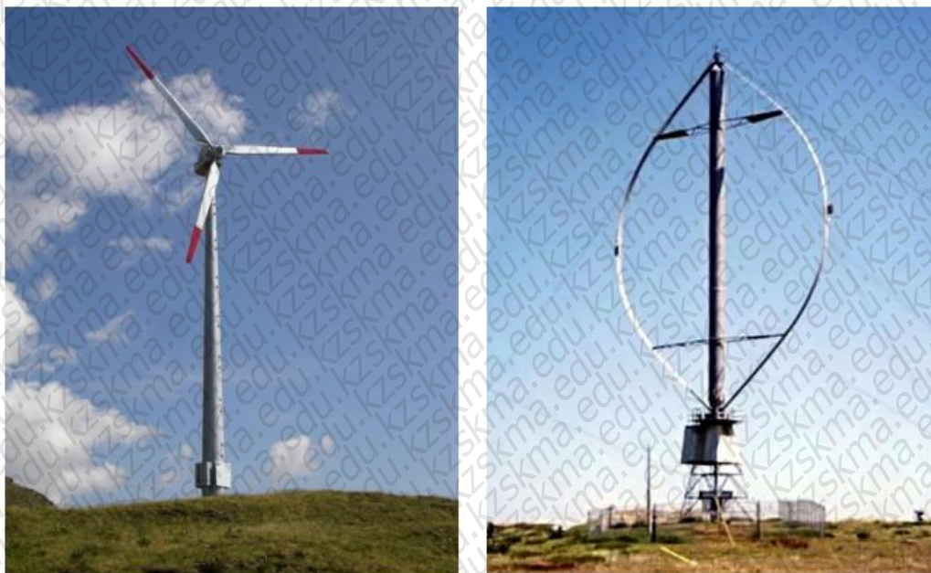
Рисунок 2.4 - Ветроустановки с горизонтальной (а) и вертикальной (б) осью вращения
